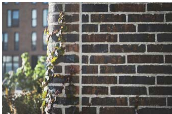
Bilden visar ett slaget tegel med vilt förband från Tegelmäster. Länk till bild: IHC5265-1024x683.jpg(1024x683) (tegelmaster.se)
